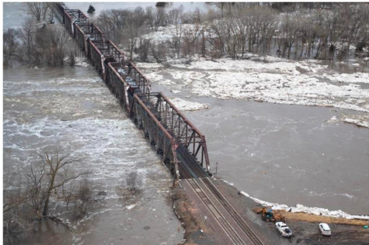
Figura 2-9: Puente Ferroviario Inundado
