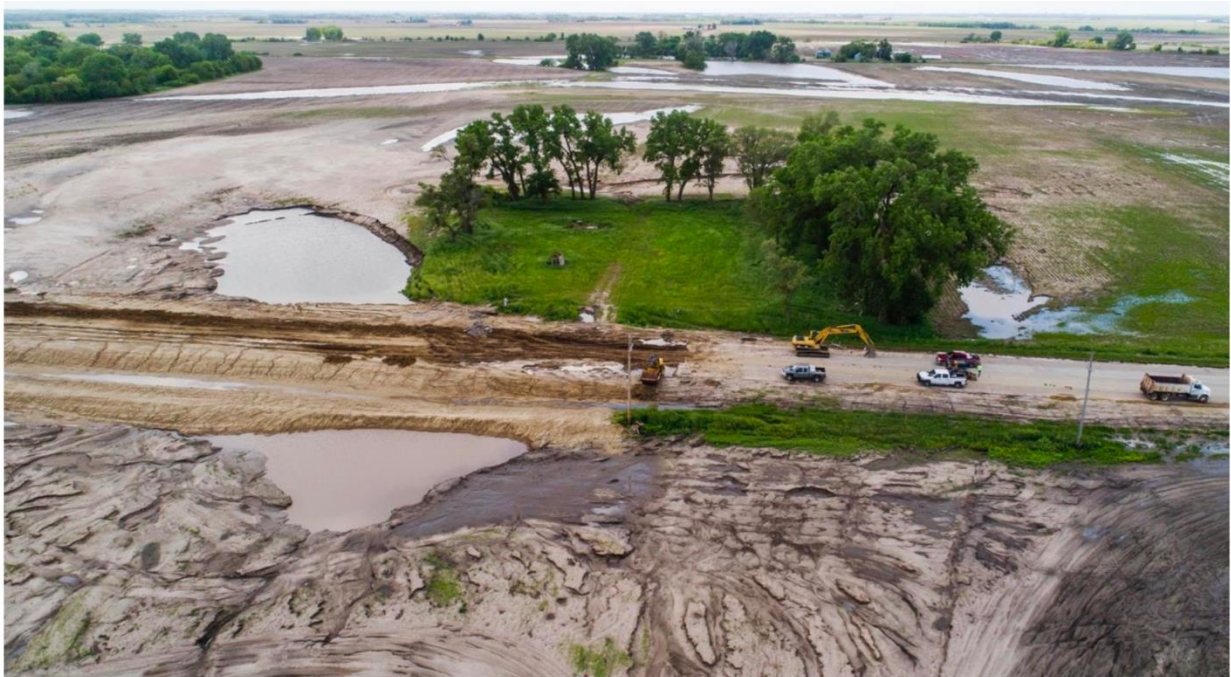
Figura 2-12: Carretera Arrasada en Reparación
