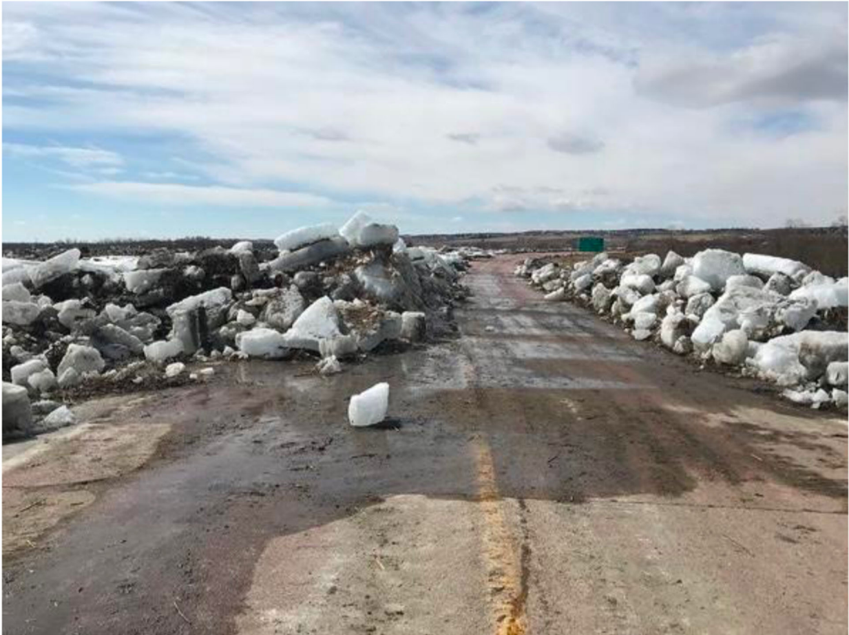
Figura 1-5: Foto de la acumulación de hielo después del desastre de 2019
