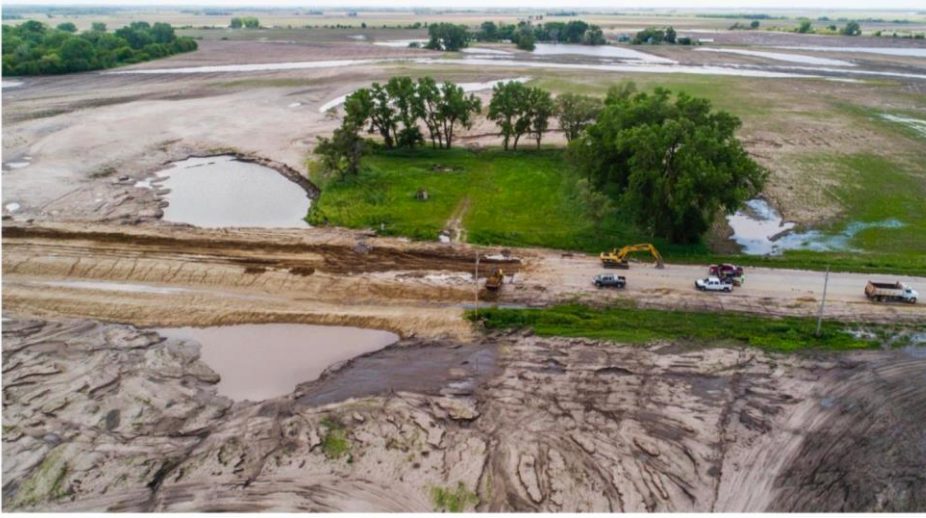
Figura 2-12: Carretera Arrasada en Reparación
